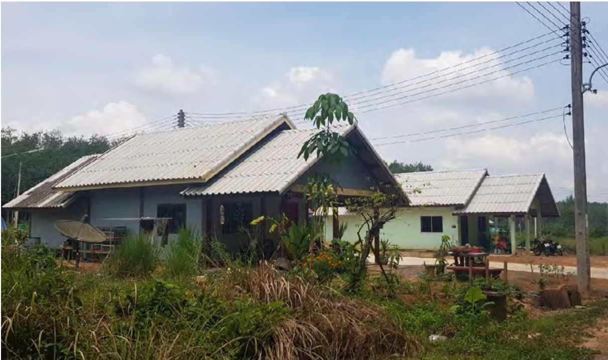
ที่อยู่อาศัยที่ถูกสร้างขึ้นโดยผู้ได้รับผลกระทบ ซึ่งได้รับเงินสนับสนุนจากโครงการกู้เงินเพื่อที่อยู่อาศัย ของธนาคารบนที่ดินที่ถูกจัดสรรไว้ให้
